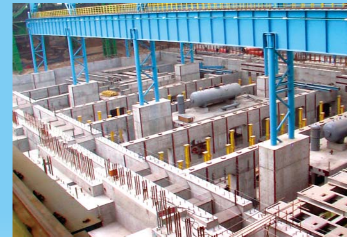
首钢迁钢2160mm热轧地下箱型基础实景
