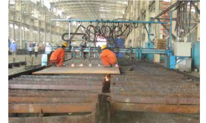
首钢迁钢3号高炉炉壳平板开孔
