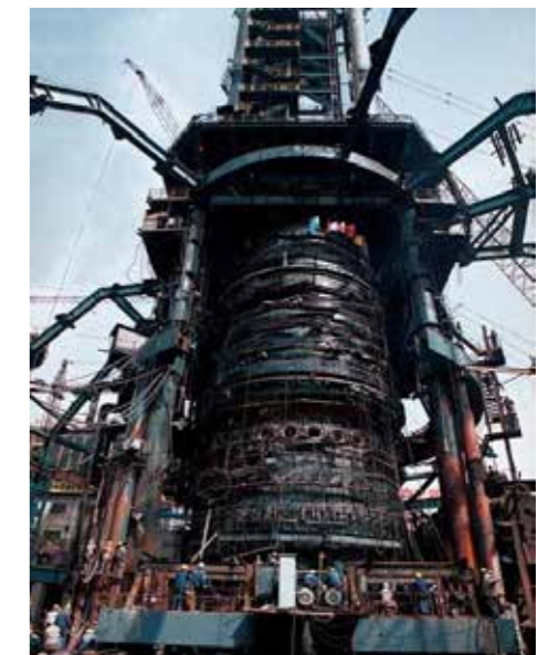
整体推移首钢4号高炉，节省近一个月的大修期
