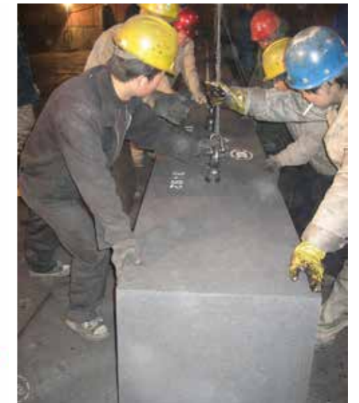
炉底大块碳砖砌筑
